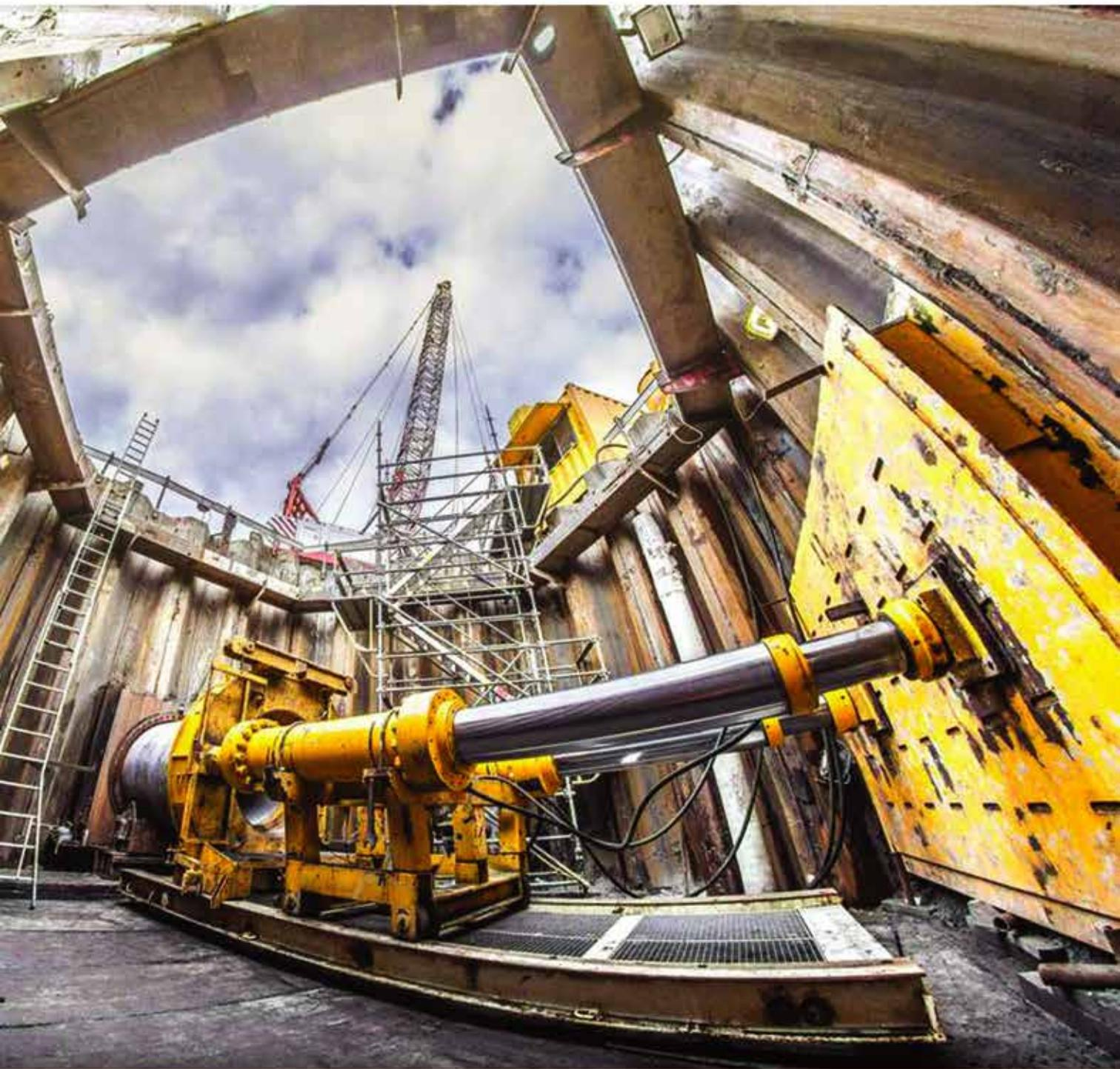
Las últimas innovaciones introducidas en el campo constructivo de instalación de conductos subterráneos, las encontramos en la aplicación de la tecnología derivada de la Microtunelería.
